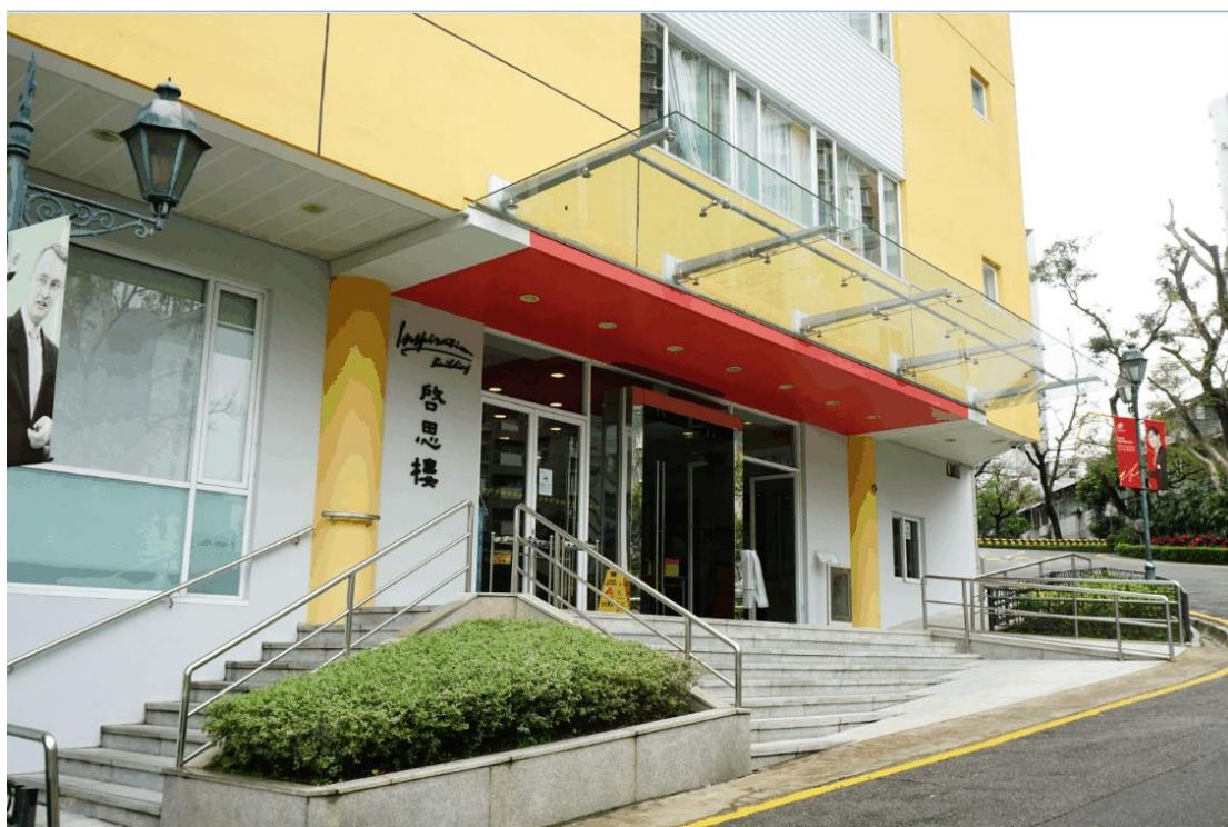
旅遊學院，澳門望廈山望廈校區啟思樓 Instituto de Formação Turística, Edifício “Inspiração” do Campus Mong-Há, Colina de Mong-Há, Macau
